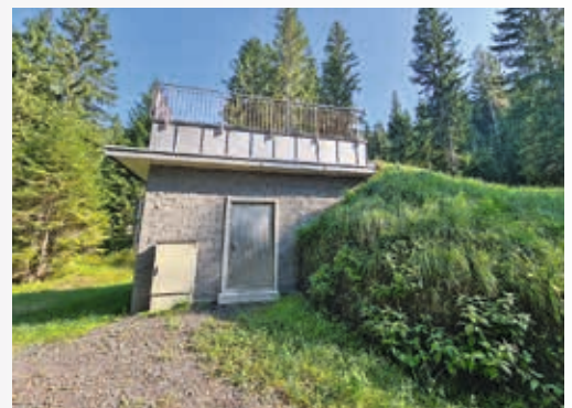
Eingang zur Schieberkammer des Hochbehälters, Ortbeton-Hochbehälter mit zwei getrennten Wasserkammern
