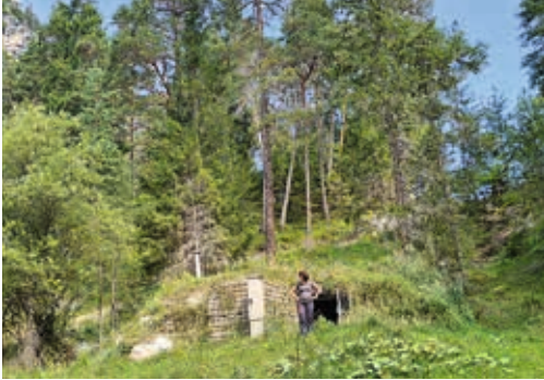
Quellstube Jeserzquelle, dient auch als Hochbehälter für die Hochzone Pölland und Matschiedl, Nutzinhalt 5.000 Liter
