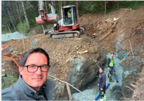
Bei einem Rohrbruch an der B111 bei Dragantschach griffen Wirtschaftshof-mitarbeiter Stefan Plesin und Manuel Schoitsch sofort ein
