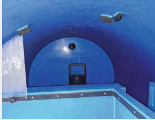
Blick in die Quellstube Jeserzquelle, Vorlagevolumen für 8 Objekte in der Hochzonenversorgung Pölland und Matschiedl
