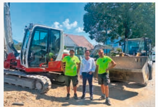
Glasfaser-Ausbau in Vorderberg: Bürgermeister Rull informierte sich bei den GNK-Mitarbeitern über den Fortschritt
