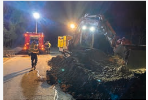
Behebung des Rohrbruchs unter der B111 unterstützt vom Baggerunternehmen Tschurtschenthaler. Bürgermeister Rull bedankt sich für das professionelle Vorgehen
