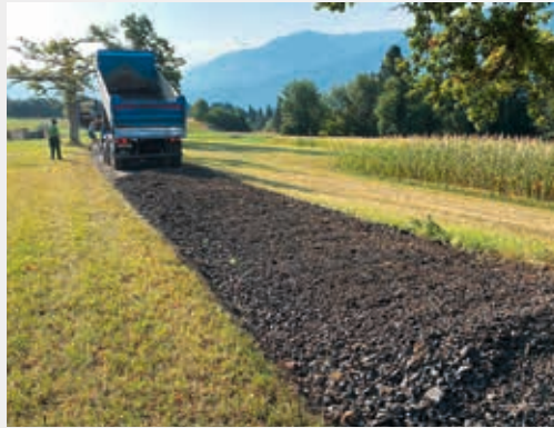
Der Weg zwischen Hadersdorf und Bichlhof wurde mit Unterstützung der Agrartechnik des Landes durch die Aufbringung von Asphaltfräsgut saniert
