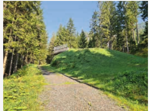
Zufahrt zum Hochbehälter Pölland, mit meterhoch überdeckter Wasserkammer
