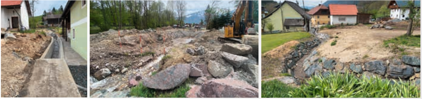
Maßnahmen zur Wildbach- und Lawinenverbauung in Sussawitsch
