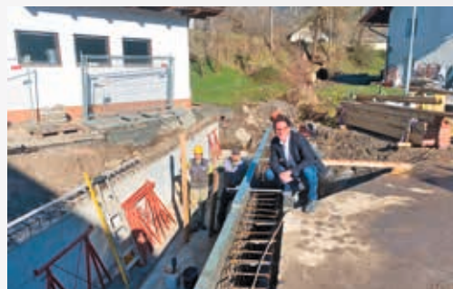
Baustellenbesichtigung der Wildbach- und Lawinenverbauung in Bach
