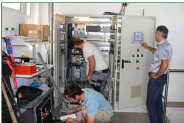
Die Sanierungsarbeiten an der Wartechnik wurden von Referent Vizebgm. René Rupnig genauestens verfolgt und überwacht
