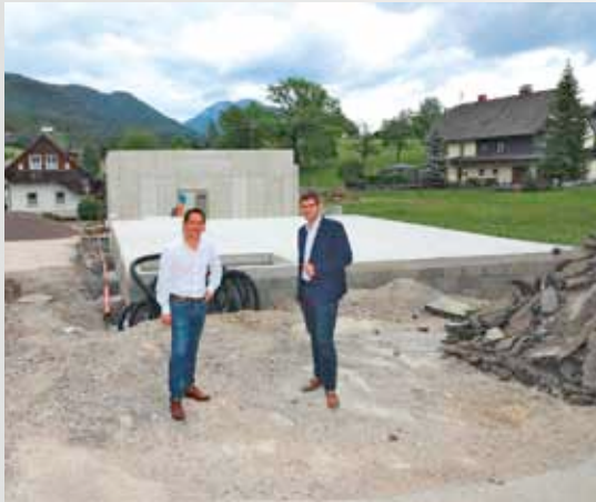
Besichtigung des Rohbaus des Feuerwehr- und Gemeinschaftshauses durch LR Gruber
