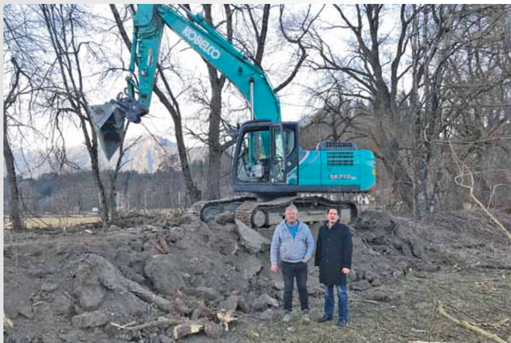
Sanierungsarbeiten und Sofortmaßnahmen am Lippschitzbach nach den wiederholten Unwettern der letzten Jahre
