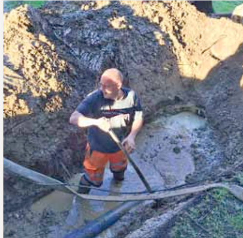
Laufende Sanierungs- und Reparaturmaßnahmen des Wasserleitungsnetzes. Am Bild: Wirtschaftshofmitarbeiter Manuel Schoitsch
