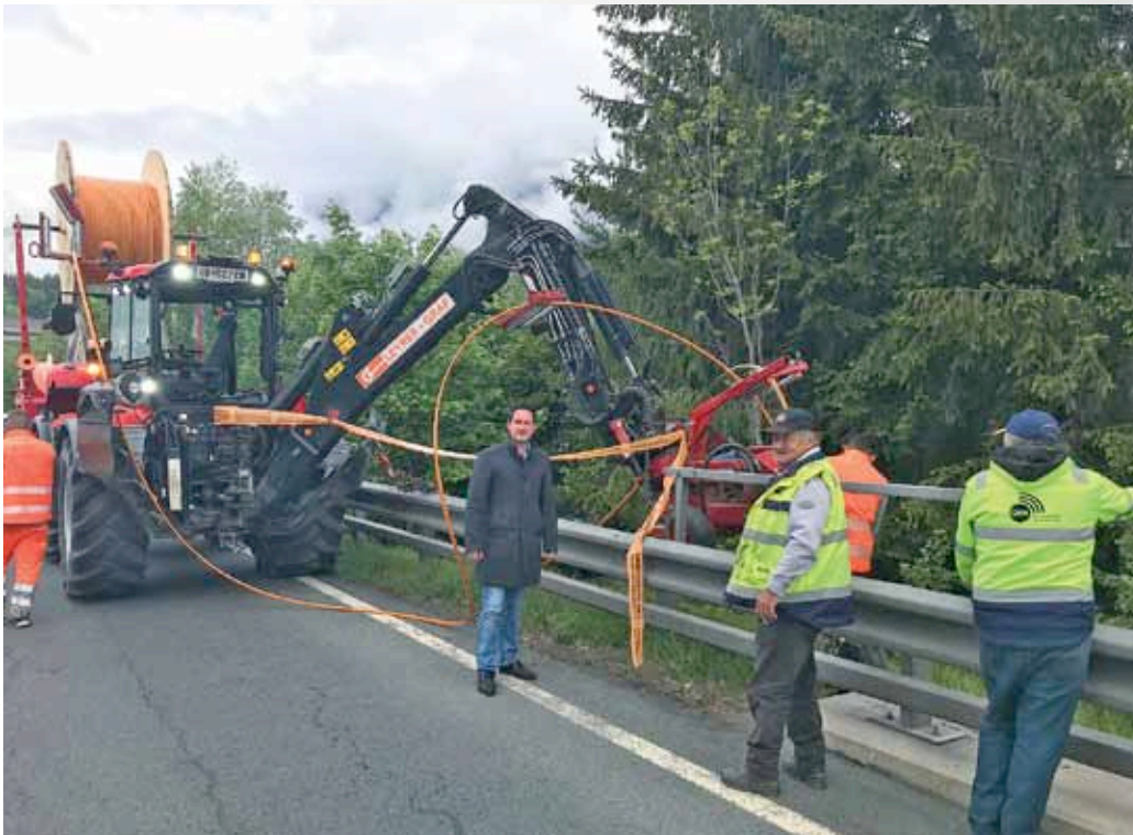
Ausbau des Glasfasernetzes entlang der B111 im Gemeindegebiet
