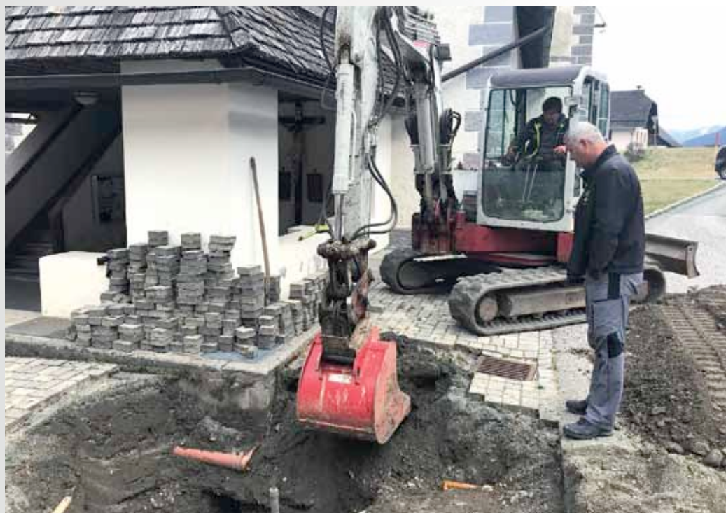
Arbeiten an der Wasserleitung nach einem Rohrbruch bei der Kirche Vorderberg
