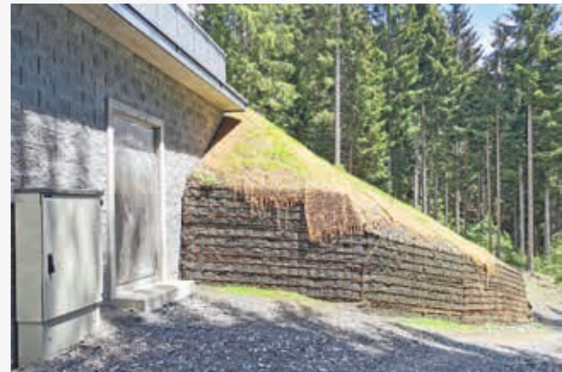
Begrünung der Hochbehälterböschung fertiggestellt Anfang Juni 2022
