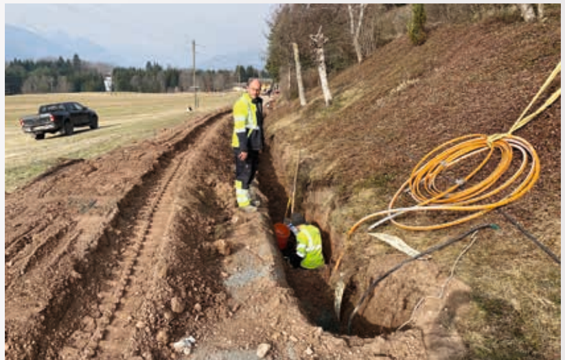
Wirtschaftshofmitarbeiter Schoitsch und Plesin bei der Verlegung der Ortsbeleuchtung sowie der Leerverrohrung für den Breitbandausbau in Sussawitsch
