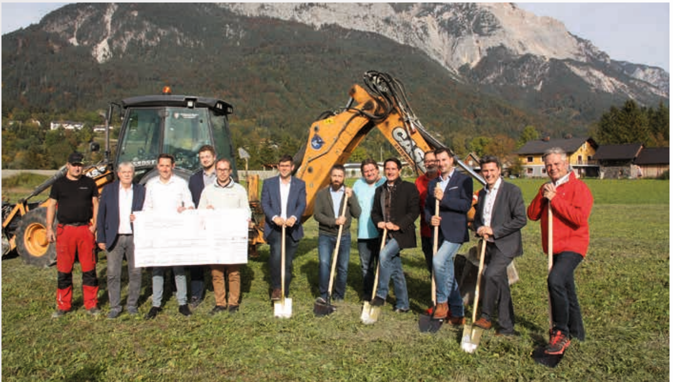
Spatenstich für das neue Altstoffsammelzentrum in Nötsch (IKZ Projekt)
