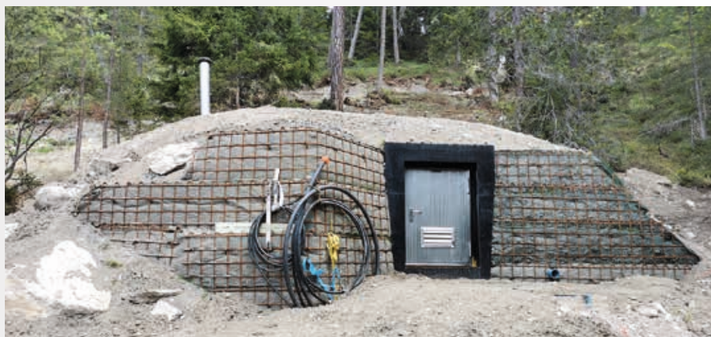
Das werksseitig vorisolierte Fertigteilbauwerk aus Polyethylen wird vollständig eingeschüttet und das umgebende Gelände wieder angepasst hergestellt
