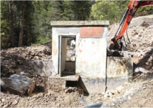
Nach Inbetriebnahme der neu errichteten Anlageteile konnte der in den 1960er Jahren errichtete Hochbehälter fachgerecht abgetragen und entsorgt werden
