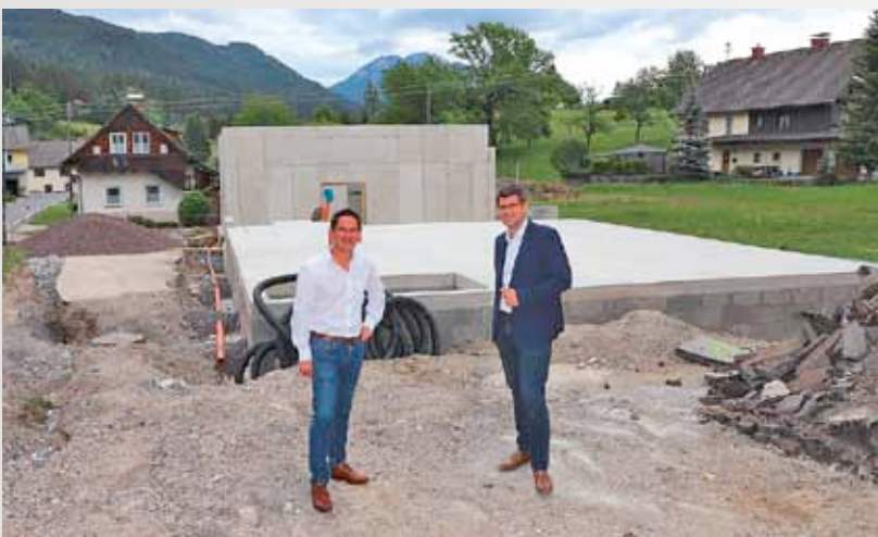
Besichtigung des Rohbaus des Feuerwehr- und Gemeinschaftshauses durch LR Gruber
