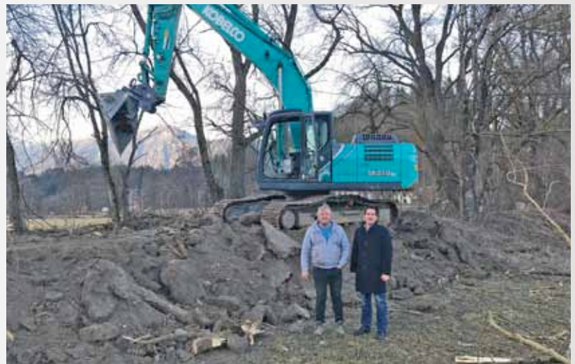
Sanierungsarbeiten am Lippschitzbach nach den wiederholten Unwettern der letzten Jahre
