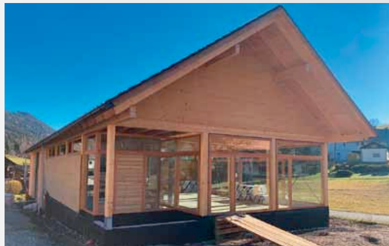
Fertigstellung der Glasfassade beim FF Haus Tratten
