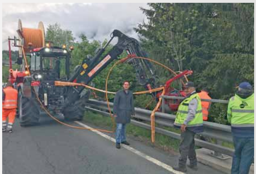
Ausbau des Glasfasernetzes entlang der B111 im Gemeindegebiet
