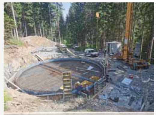
Bewehrungseinbau und Fugenbandeinbau in der Bodenplatte der Wasserkammer
