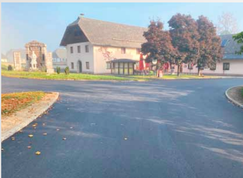
Sanierung des Dorfplatzes Vorderberg sowie der L27 und L23
