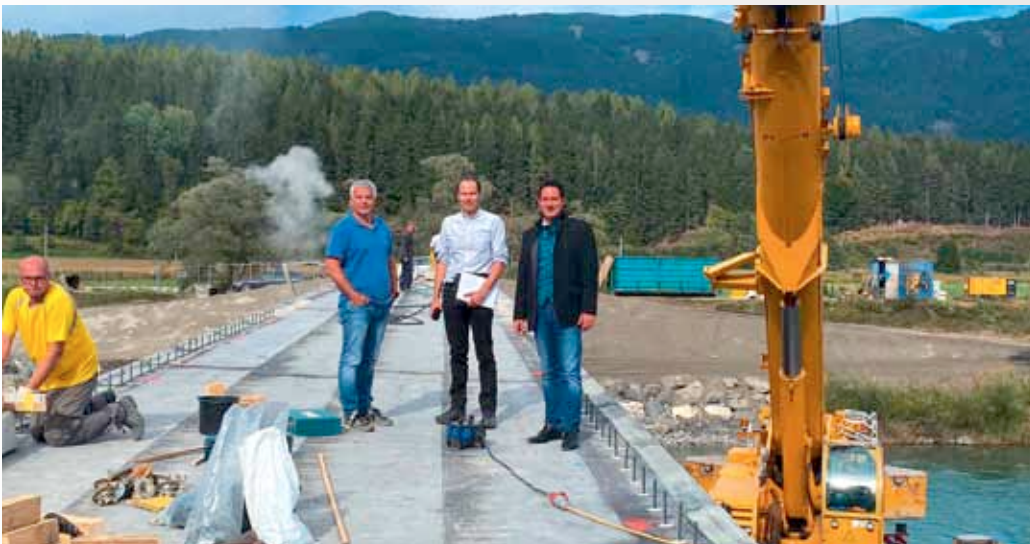
Baubesichtigung mit Bernhard Jäger (Steinerbau) und DI Klaus Hudelist (ZKP)
