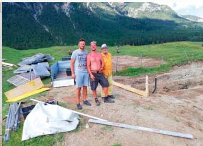
Fundamentarbeiten in Eigenregie. Am Bild von links: Rene Druml, Christopher Pernull und Anton Binter
