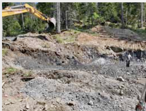
Baugrubenaushub für den Neubau des Hochbehälters Pölland, Felsabtrag
