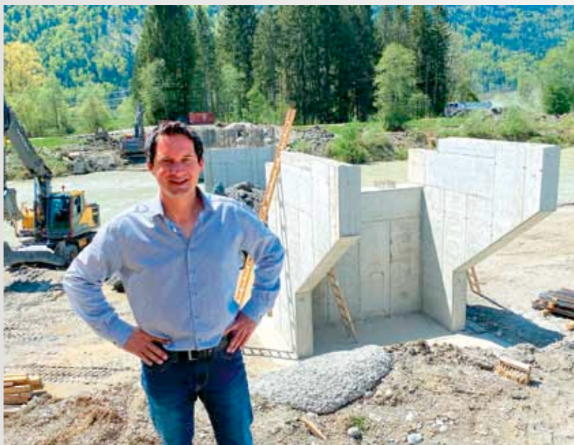
Bürgermeister Rull bei der Baustellenbesichtigung
