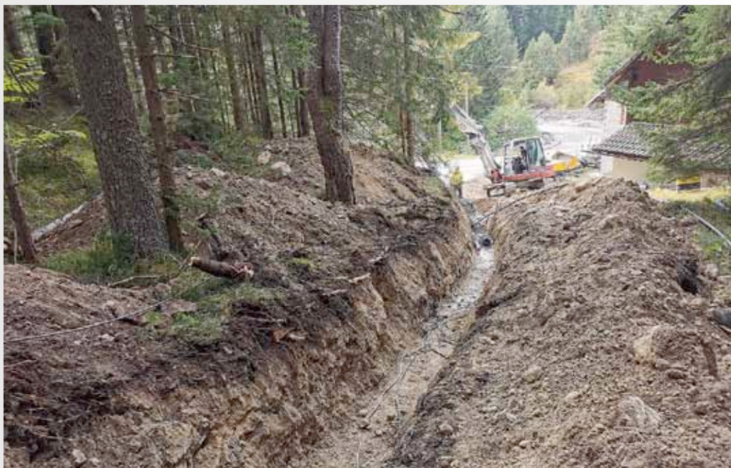
Offener Grabenaushub im bestehenden Forstweg
