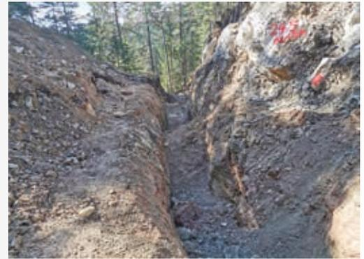
*Um den Betrieb über die gesamte Bauzeit mit dem bestehenden Quellableitungsrohr weiter aufrecht zu erhalten, musste die neue Quellableitung parallel dazu in den steilen Felshang hinein verlegt werden*
