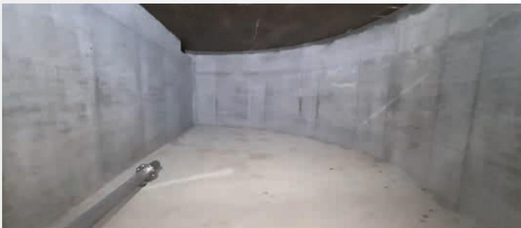
Blick in eine der beiden Wasserkammern des Hochbehälters Pölland. Jede Wasserkammer hat ein Fassungsvermögen von 100.000 Liter Trinkwasser
