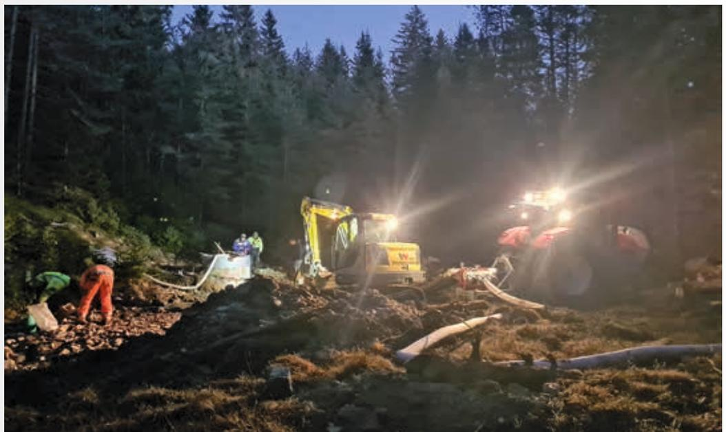
*Finale bei der Herstellung der Quellableitung Jeserzquelle. Bis in die Nacht hinein wurde intensiv am Anschluss an die bestehende Quellfassung gearbeitet*
