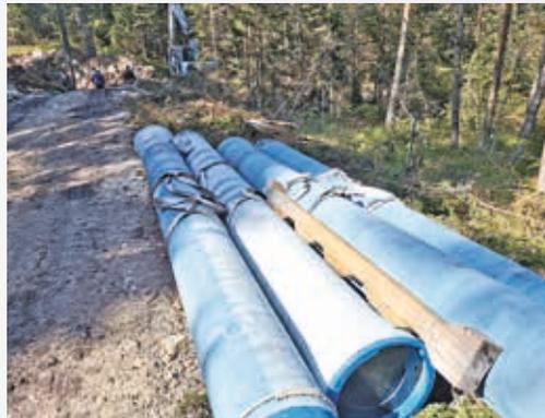
*Die 6 m langen und 707 kg schweren Duktilegussrohre mit einem Innendurchmesser von 40 cm*
